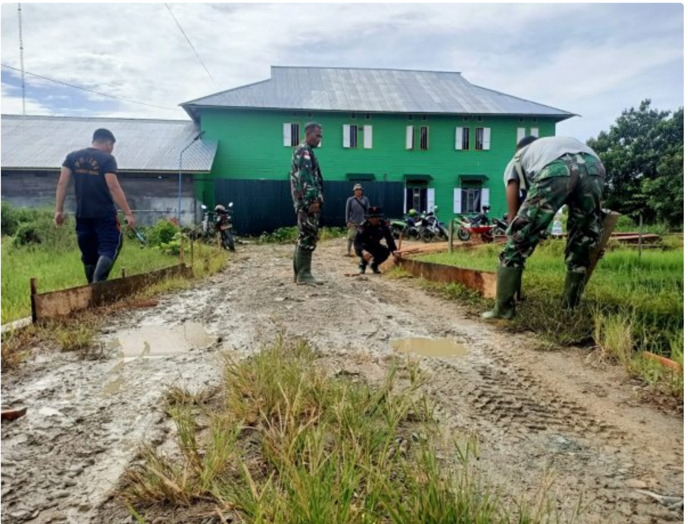
Cuaca Tak Menentu, Satgas TMMD Wiltas Ke-118 Kodim 0910/Malinau Kebut Pengerjaan Sasaran fisik
