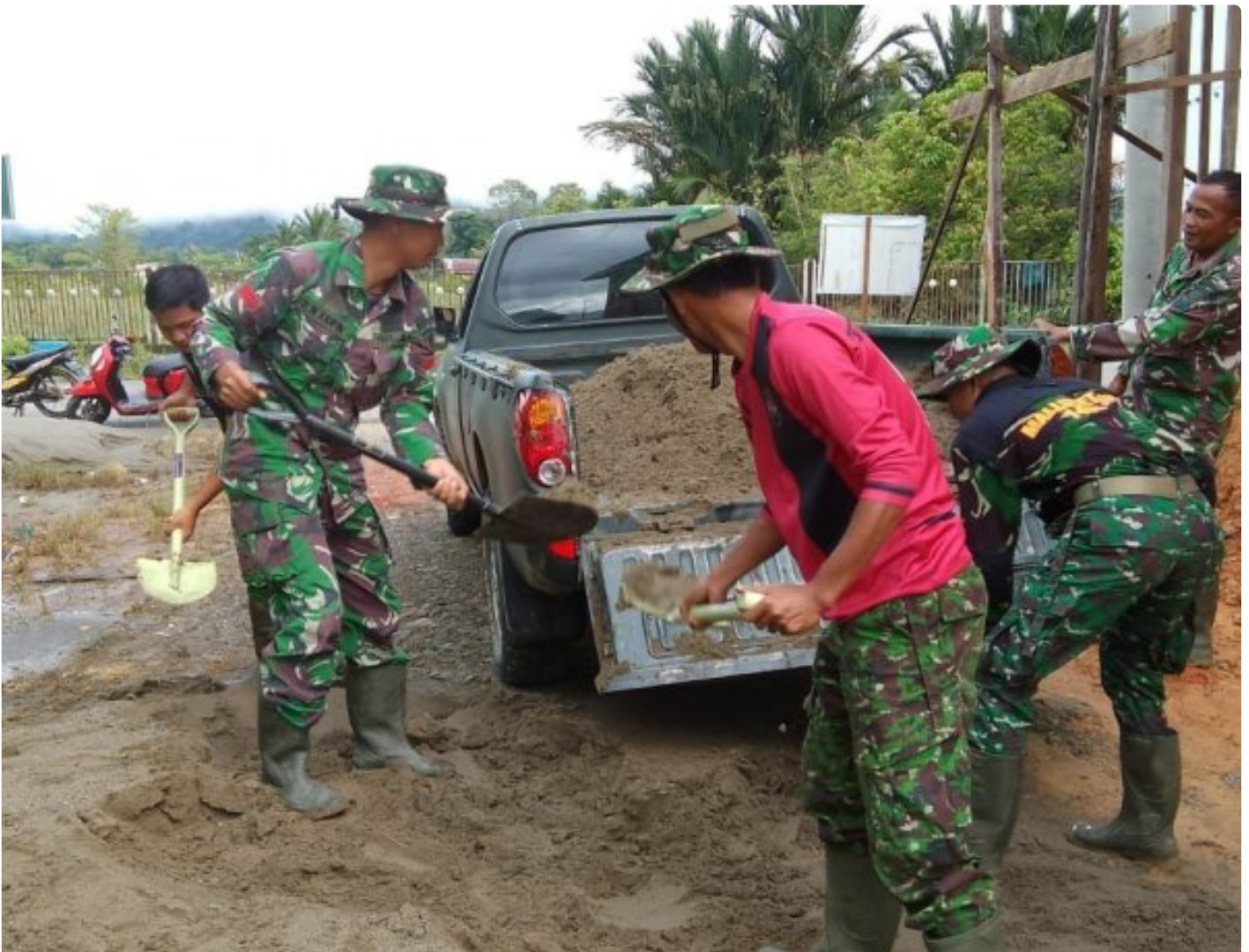
Gunakan Mobil Dinas, Satgas TMMMD 118 Langsir Pasir Di Sasaran Semenisasi Jalan
